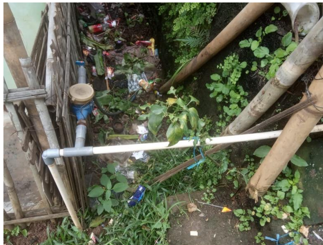
Salah satu meteran air untuk mengukur pemakaian air bersih di rumah warga
