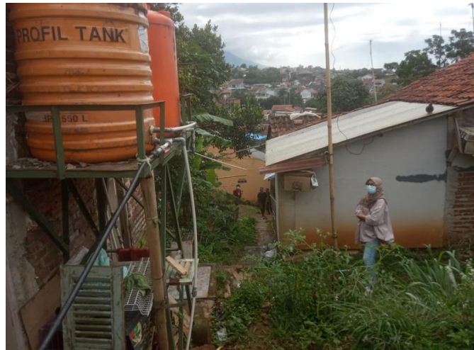
Dua buah toren warga untuk menampung air dari sumur bor, dengan kapasitas total 1 m 3
