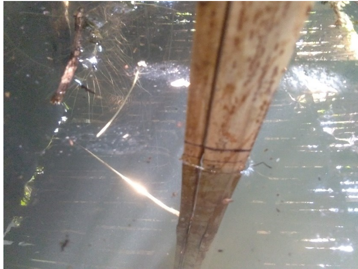
Gambar 4 Kondisi awal bak penampungan
