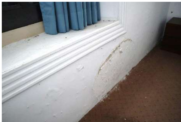
Gambar 2.18 Acian dinding terkelupas akibat rembesan air tanah
