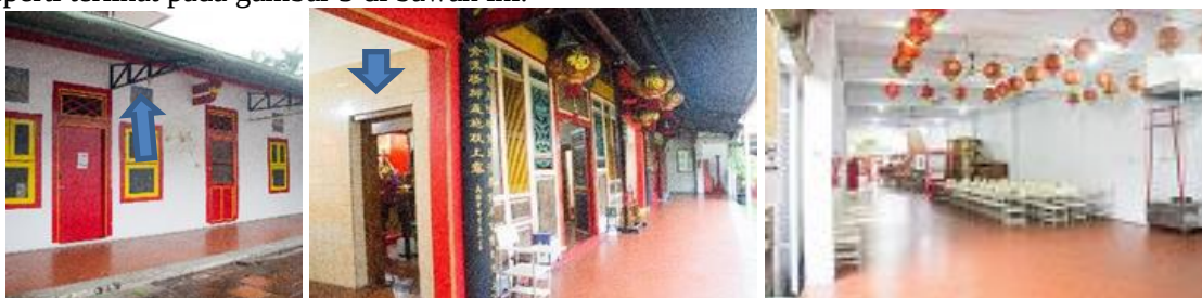
Gambar 3: Rangka kanopi di koridor luar dan dinding ruang altar yang dilapis keramik dan interior bangunan tahap 3
