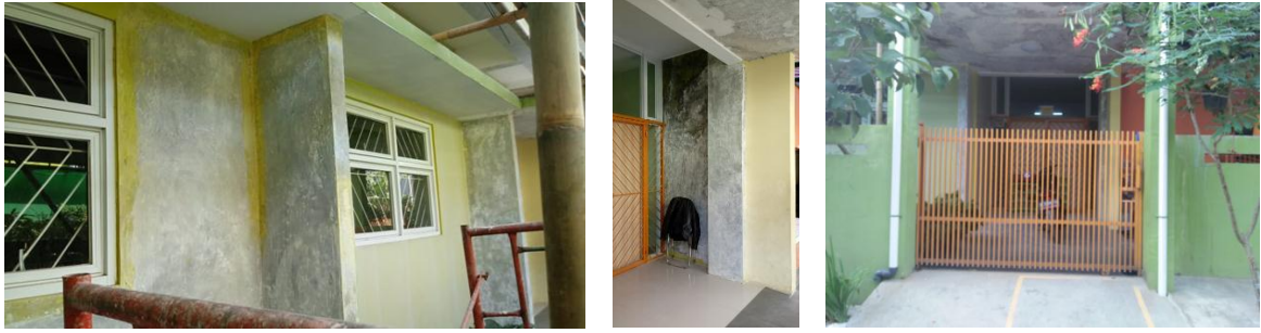
Gambar 4.3 Pekerjaan pelapisan plamir
