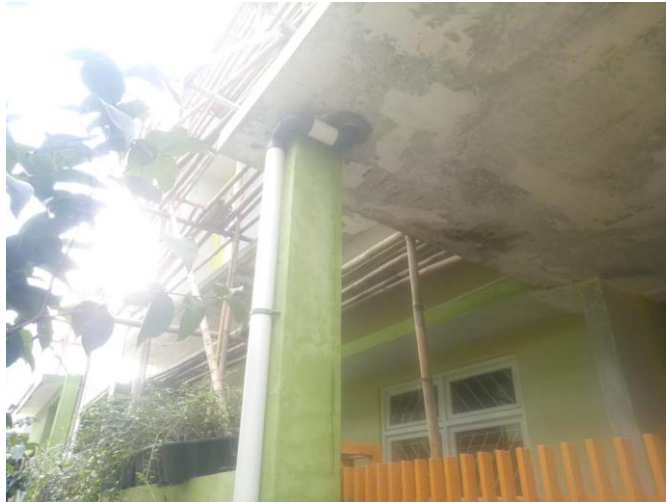
Gambar 3.4 plafon kanopi yang bocor
