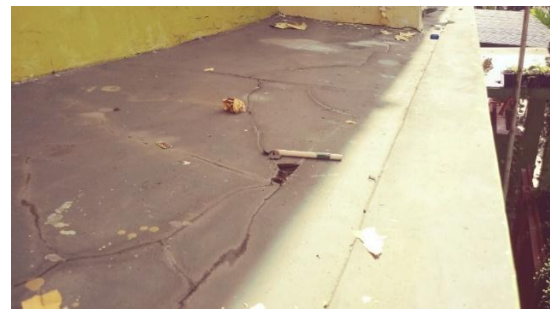
Gambar 3.2 Kerusakan pada cat dinding dan teritis atas
