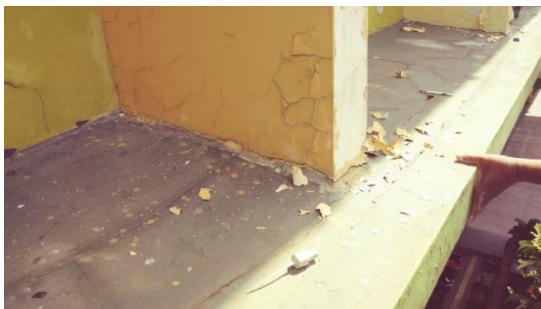
Gambar 3.2 Kerusakan pada cat dinding dan teritis atas
