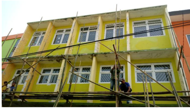
Gambar 4.1 Foto pemasangan esteger
