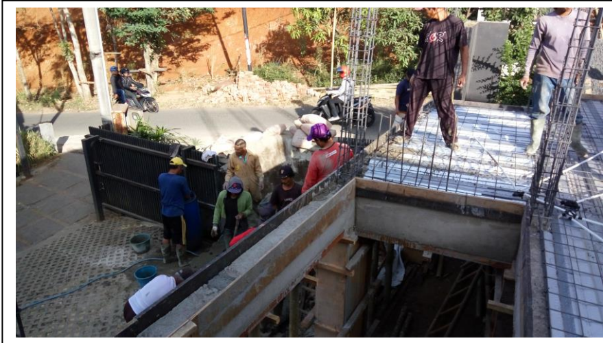
Proses persiapan pengecoran lantai
