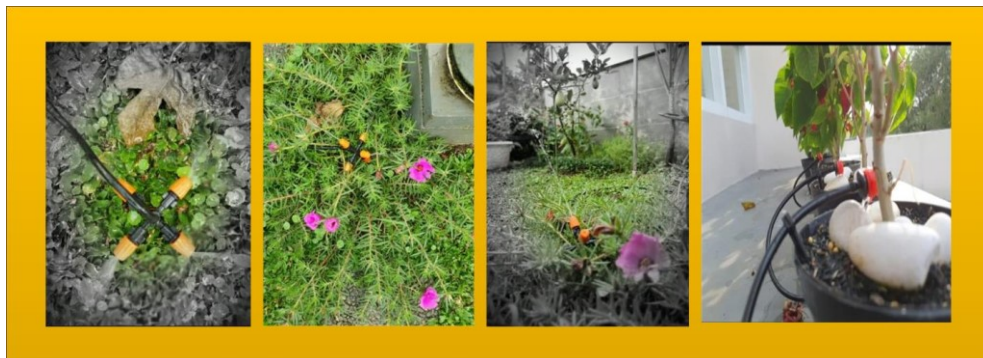
Gambar 3. Instalasi Sistem Irigasi
