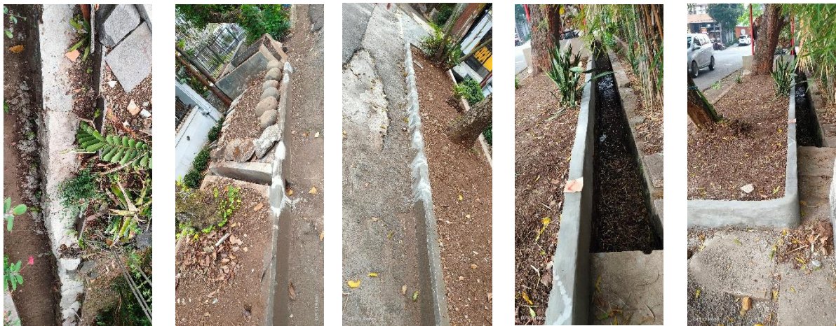
Gambar 3.10 Hasil perbaikan kerusakan minor pada saluran di depan Jln Kyai Luhur no 8, Jln. Kyai Luhur no. 10, dan Jln. Hasanudin no 20.
