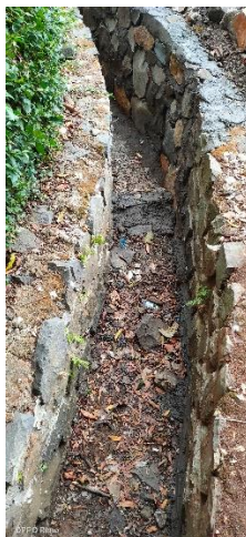
Gambar 3.7 Hasil perbaikan saluran di depan Jln. Hasanudin 18.
