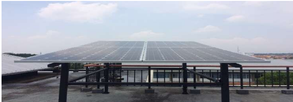
Gambar 2. Komponen Utama PLTS: Modul Surya
