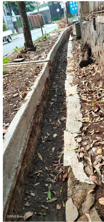
Gambar 3.8 Hasil perbaikan saluran di samping Jln. Hasanudin 18.
