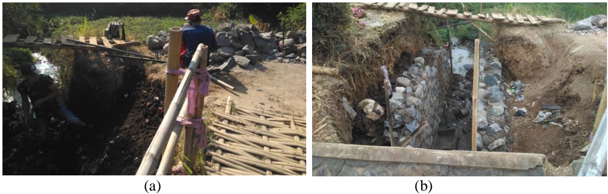
Gambar 4 (a) Pengerukan tanah (b) Pembuatan pondasi
