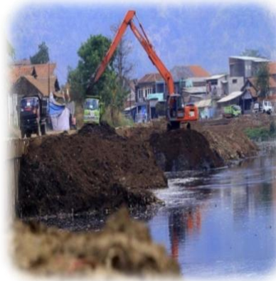
Gambar 4.6 Pengambilan Sampah di Sungai (Kiri), Pengerukan Sedimentasi (Tengah) dan Pengecoran Pipa Buangan Industri (Kanan)
