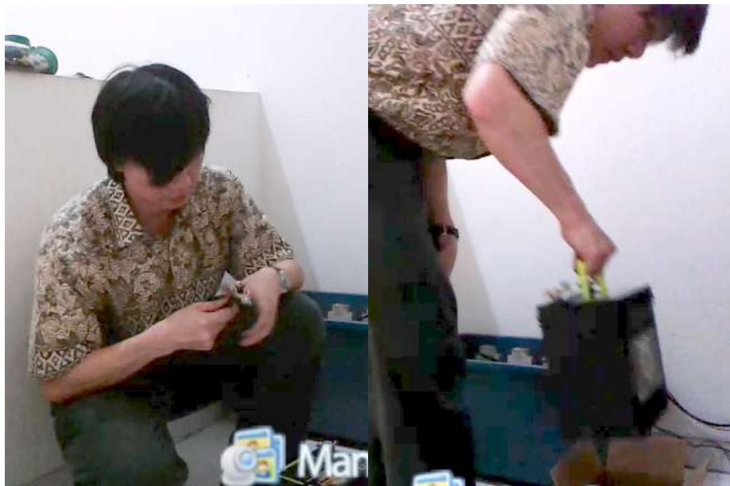
Foto saat pemasukan ups baru ke kotak panel dan saat penandaan polaritas kabel penghubung
