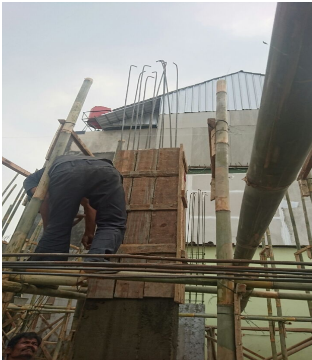
(Foto 24. Bekisting Kolom dan Pengecoran kolom)
