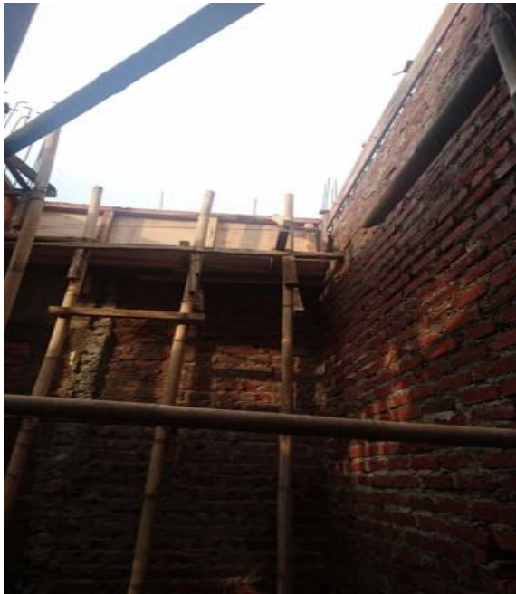
(Foto 27: Pengecoran Balok Lantai 1)
