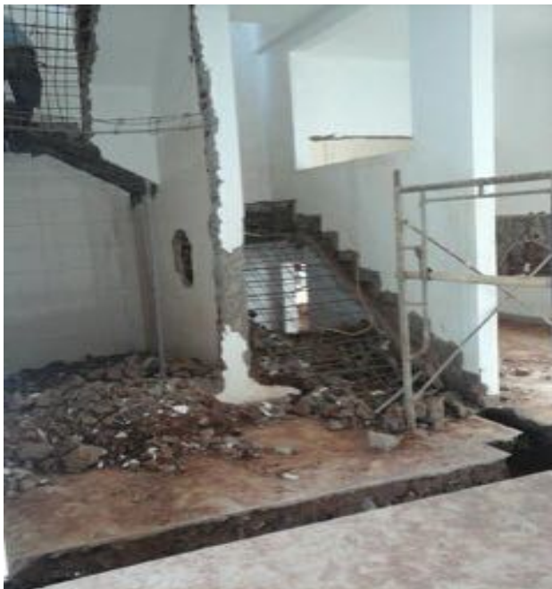
(Foto 6 : Pembongkaran tangga eksisting)
