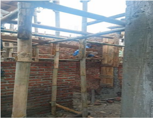
(Foto 25. Membuat Dinding Lantai dasar)
