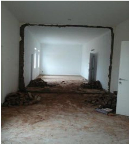
(Foto 5 : pembongkaran dinding dalam pembatas kavling 2 dan 3)
