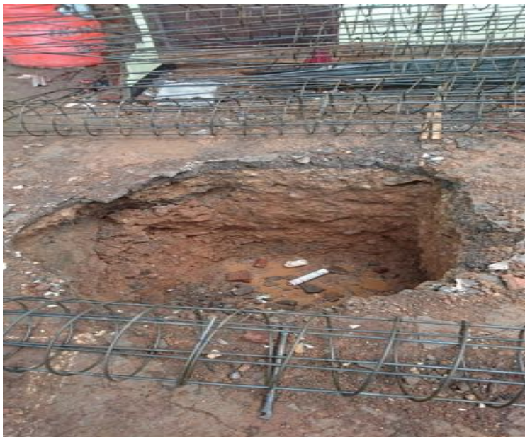
(Foto 18: Pembuatan lubang Pondasi)
