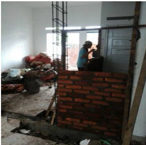
(Foto 10 : Pembuatan dinding didalam ruang)
