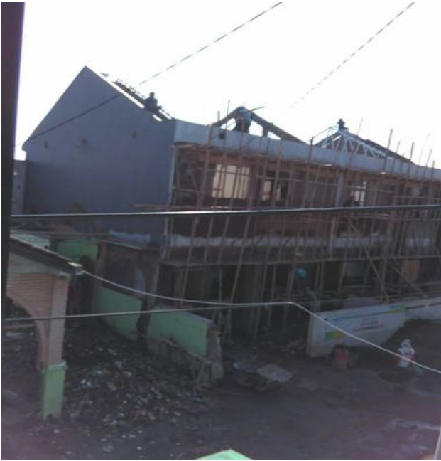
(Foto 7 : Pembongkaran atap eksisting)
