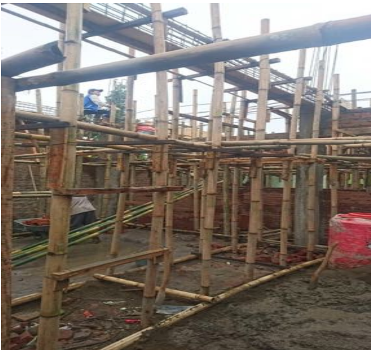
(Foto26. Membuat Perancah dan Bekisting Balok Lantai 1)
