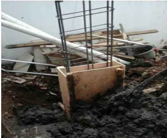
(Foto 9 : Pembuatan kolom)
