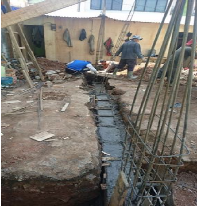
(Foto 23. Pengecoran Sloof)
