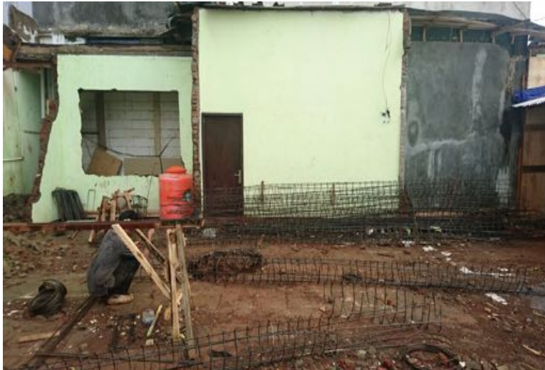
(Foto 17: Pembuatan Tulangan Pondasi Strauss)
