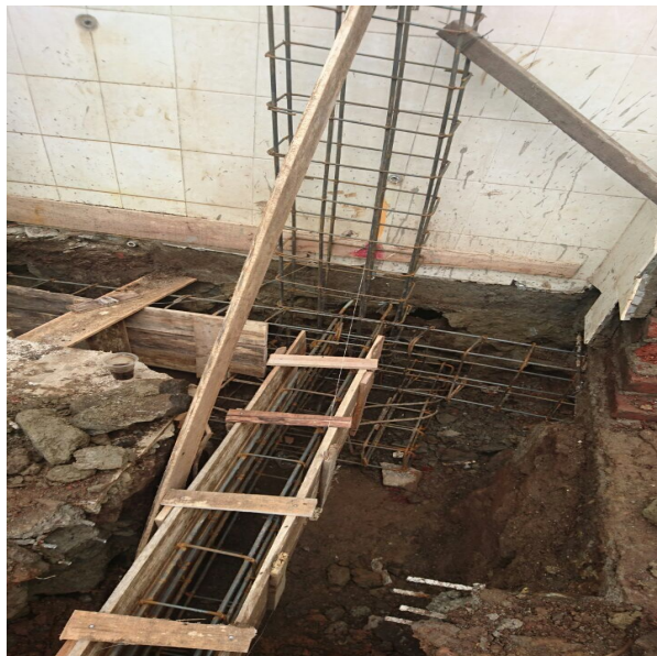
(Foto 22. Pemasangan Bekisting Sloof dan Pemasangan Tulangan Kolom)
