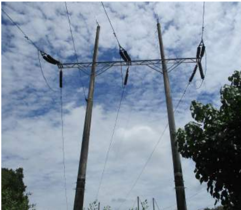
Gambar 13. Jaringan transmisi 150 kV dengan pole tower di daerah Pesanggaran – GH 57 (Area dekat hutan bakau)
