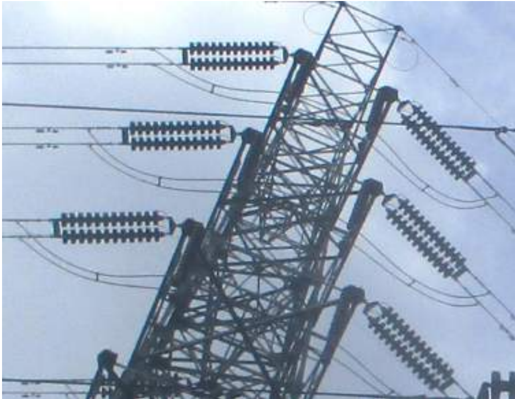
(d) Konfigurasi DT / DT ( Suspension Disc )
