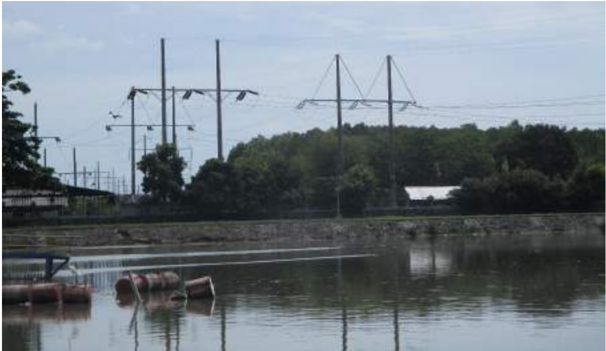
Gambar 12. Jaringan transmisi 150 kV dengan pole tower di daerah Dam Estuari (Area dekat rawa / air payau)
