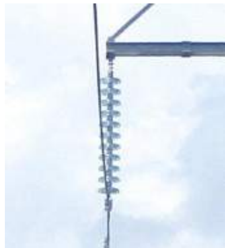
(b) Konfigurasi SS ( Suspension Disc )
