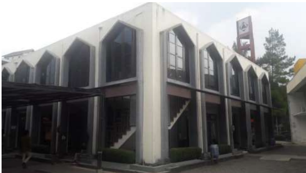
Gambar 4-10 Kondisi sekitar lokasi objek studi
