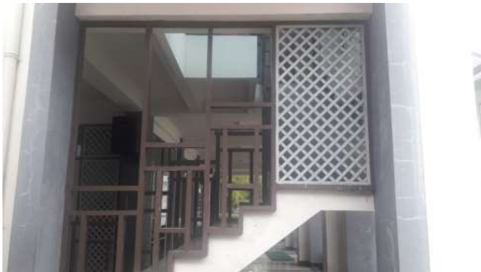
Gambar 4-9 Kondisi sekitar lokasi objek studi
