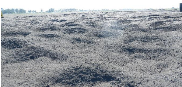
Gambar 7 Crater yang terbentuk akibat DC
