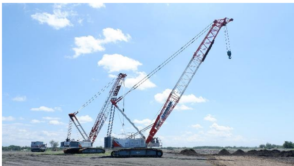
Gambar 6 Pekerjaan Dynamic Compaction di NYIA
